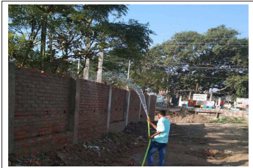
BERHAMPORE STP SITE
